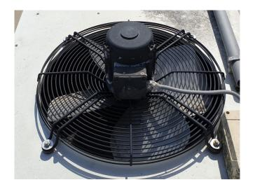
AFT71/6A-7 /P01 -33397 380/220 0,8/1,4 A. 910 /min 0,18 kW 50 Hz cos\$ 0,73 Th.CI. B TR 55 VDE\_0530
